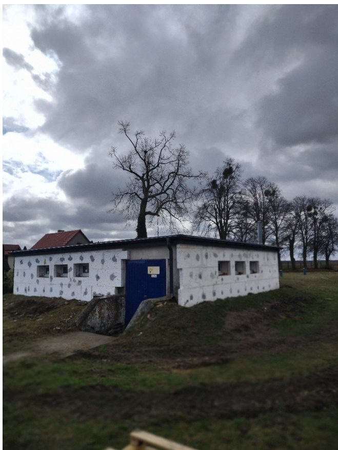
Rysunek 7-10 Stacja uzdatniania wody w Lubiewie
