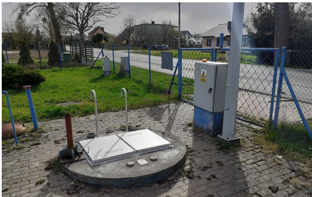
Rysunek 7-3 Przepompownia ścieków w Bysławku
