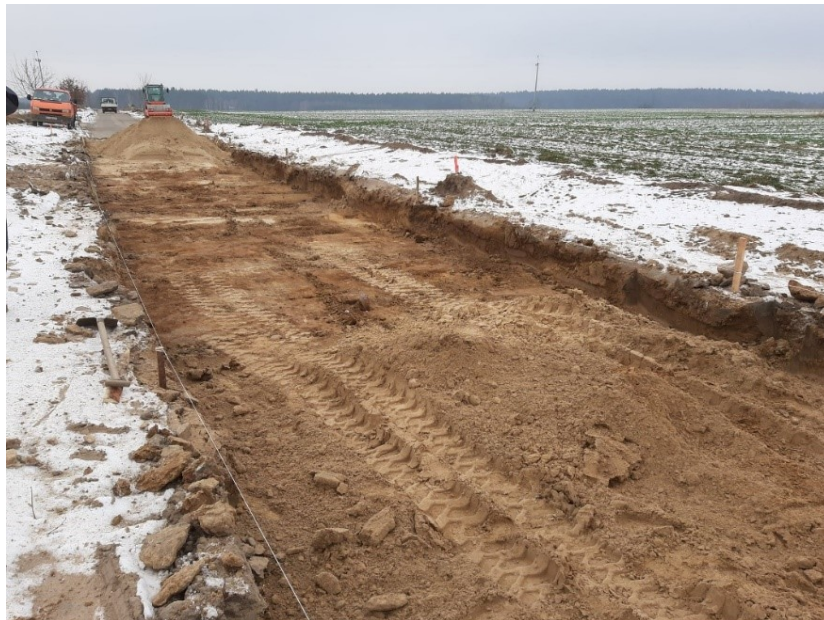
Rysunek 7-9 Roboty budowlane na drodze
