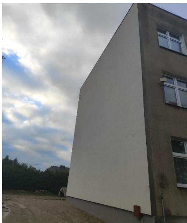
Rys. 5-8 Docieplenie ściany szczytowej budynku mieszkalnego przy ul. Wojska Polskiego 16
