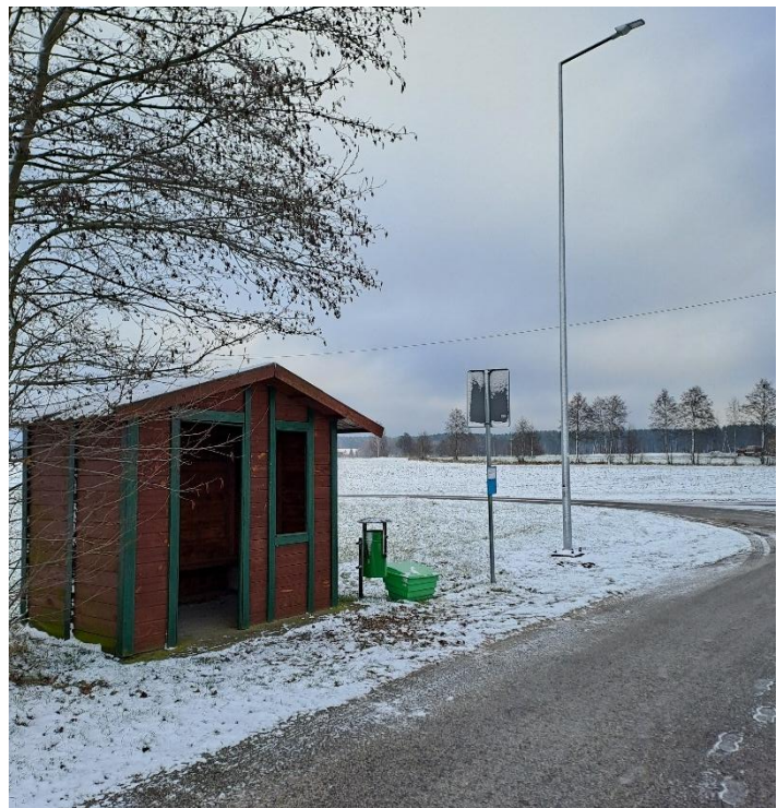
Rys. 5-11 Budowa elektroenergetycznej sieci oświetlenia drogowego dla skrzyżowania i przystanku PKS na drodze gminnej w Lubiewicach
