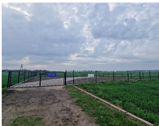
Rys. 5-4 Budowa studni zastępczej nr 3A w Bysławiu
