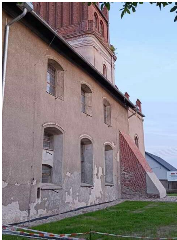
Rys. 5-24 Wykonanie przeciwwilgociowej izolacji fundamentów oraz prace konserwatorskie i restauratorskie trzech przypór dla zespołu kościoła i klasztoru w Bysławku
