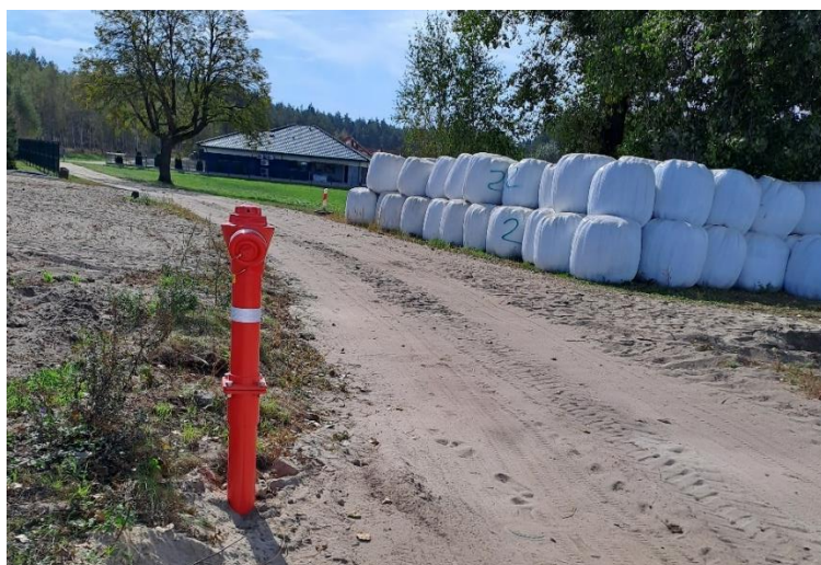
Rys. 7-2: Hydrant zamontowany w ramach budowy sieci wodociągowej
