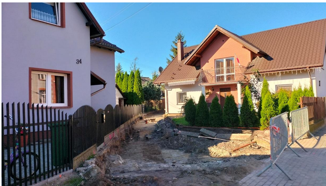
Rys. 7-13: Roboty budowlane na drodze
