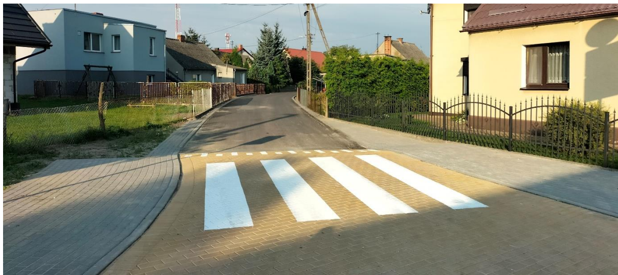
Rys.: 7-7 Przebudowana droga
