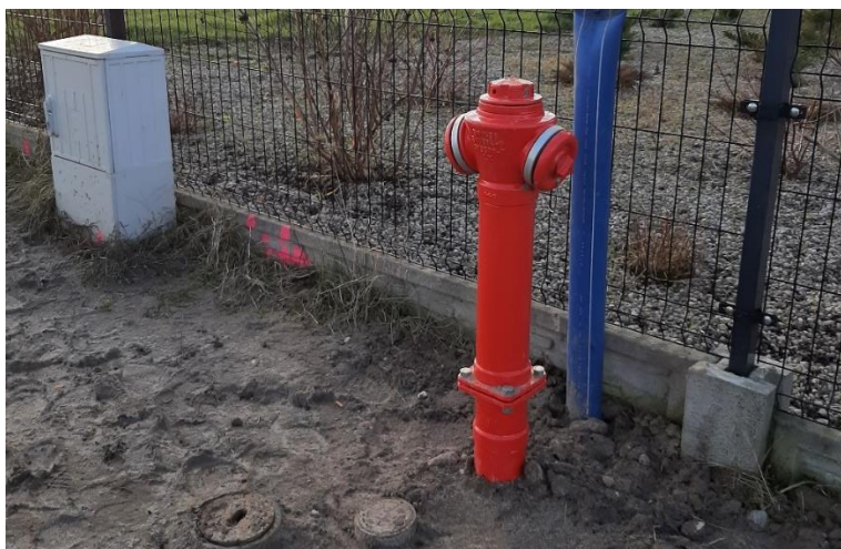
Rys. 7-1: Hydrant zamontowany w ramach budowy sieci wodociągowej
