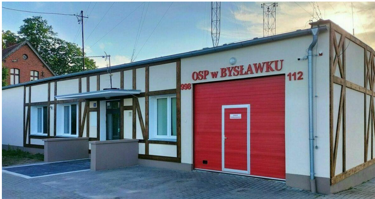
Rys. 7-6: Rozbudowa budynku świetlicy wiejskiej w Bysławku
