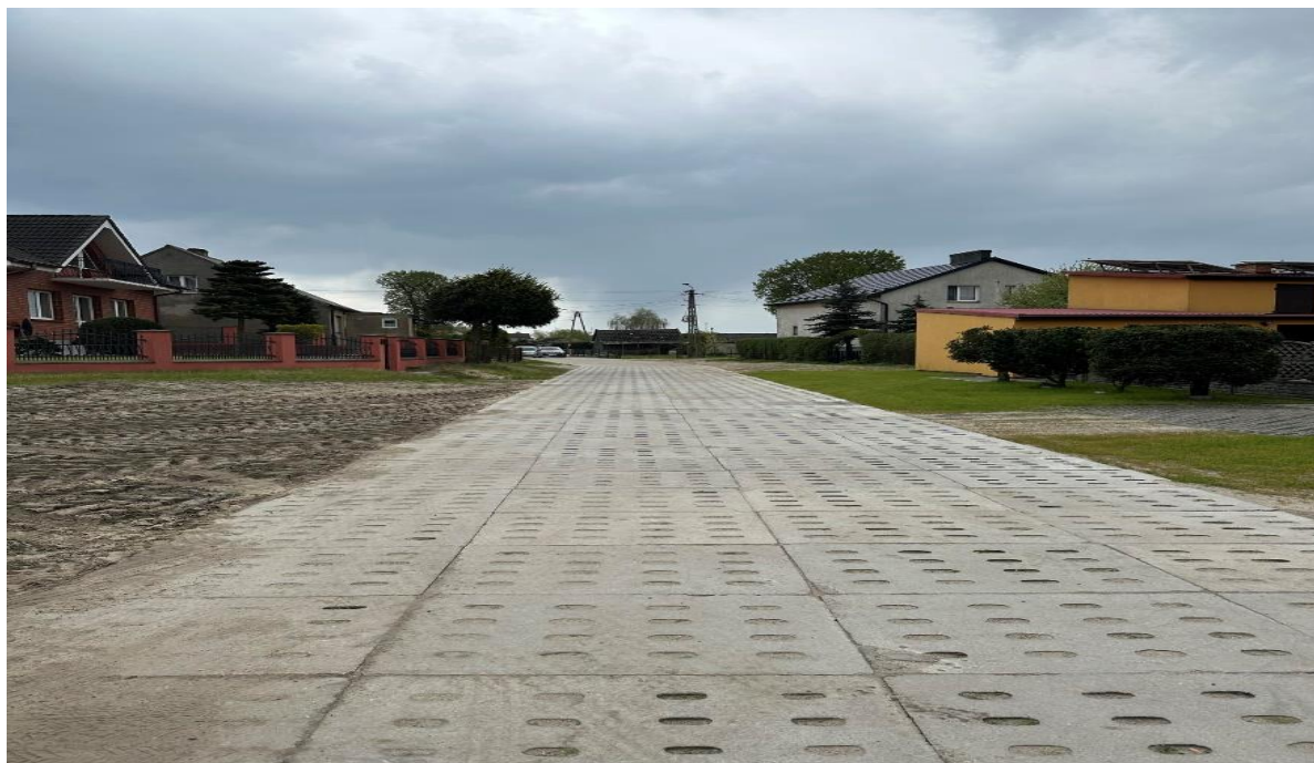
Rys. 9-10: Utwardzenie płytami jumbo
