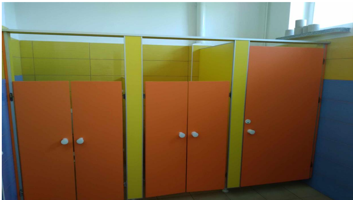
Rys. 9-5: Remont łazienki w Bysławiu
