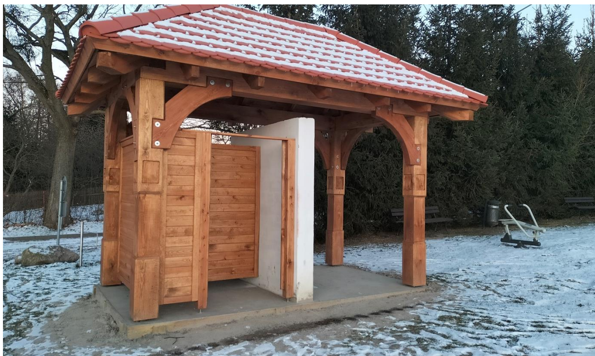
Rys. 7-11: Budowa plażowych prysznic z przebieralniami
