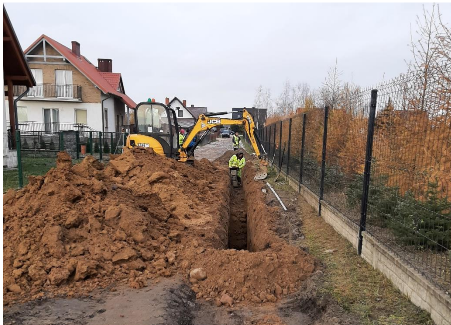
Rysunek 7-11 Roboty budowlane w trakcie rozbudowy sieci wod-kan.
