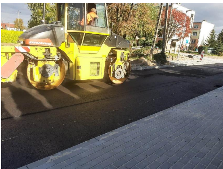
Rysunek 7-9 Roboty budowlane na drodze
