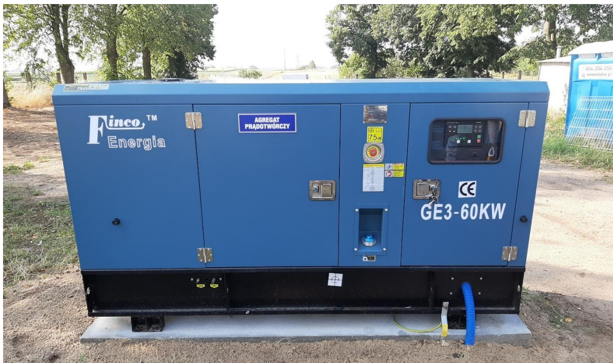
Rysunek 7-2 Agregat prądowórczy wraz z układem samoczynnego włączania rezerwy
