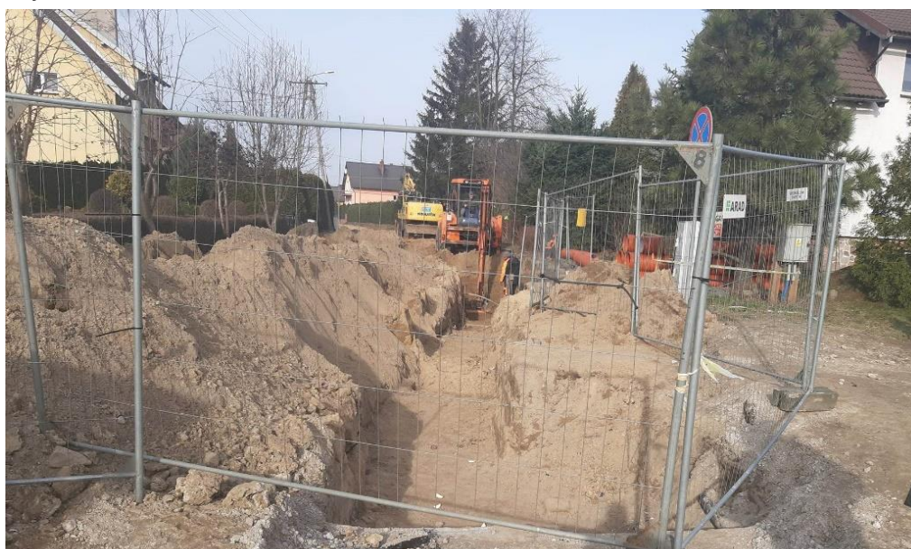
Rysunek 7-12 Roboty budowlane na drodze
