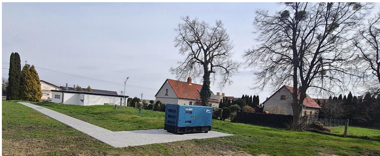
Rysunek 9-4 Wykonanie chodnika na terenie SUW w Lubiewie
