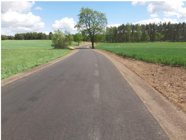
Rysunek 7-8 Przebudowana droga
