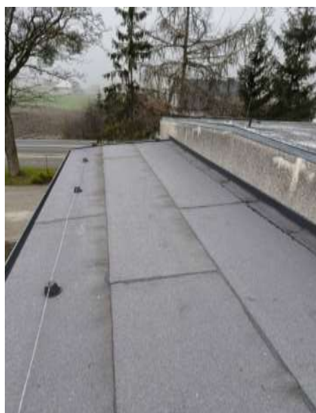
Fot. 10. Wymiana pokrycia dachowego na części budynku świetlicy wiejskiej w m. Wetpin
