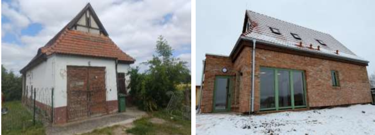
Fot. 18. Przebudowa i termomodernizacja budynku położonego w Bystawiu przy ul. Wodnej 8 – widok przed i po wykonaniu założonych prac.
