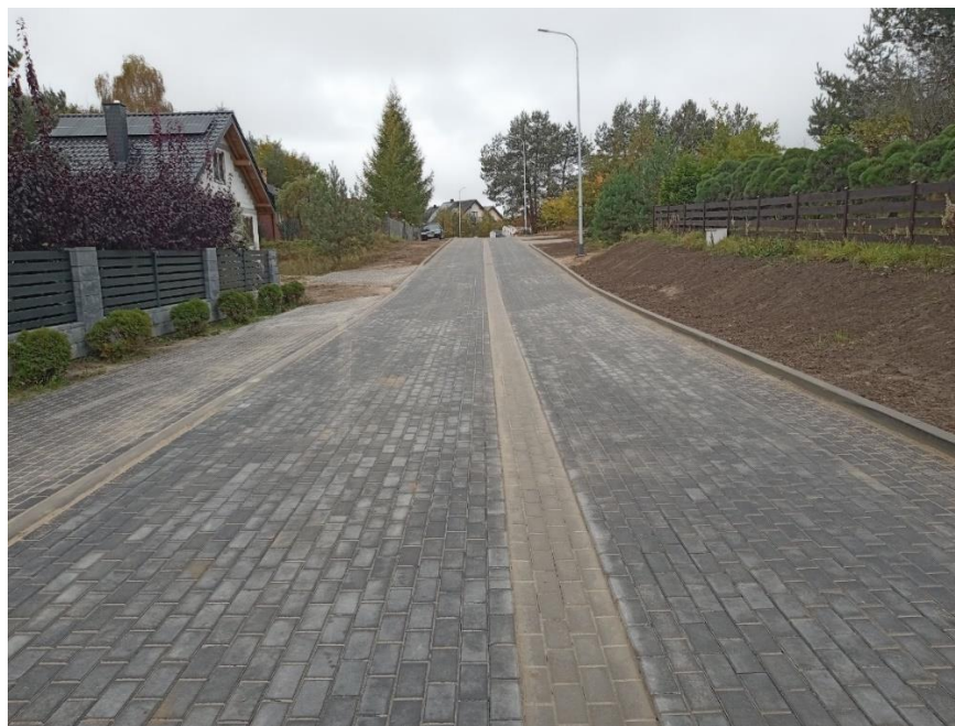
Rycina 29. Realizacja zadania – budowa dróg na osiedlu Północ II ul. Jaśminowa i Kalinowa wraz z kanalizacją deszczową i oświetleniem drogowym - etap II.
