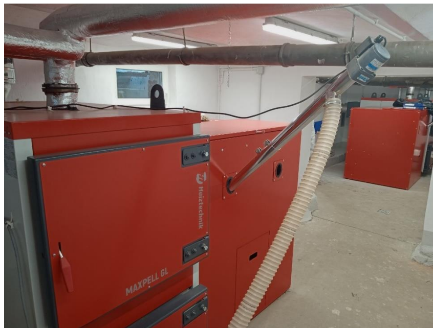
Rycina 33. Przebudowana kotłownia zlokalizowana w tzw. „Czerwonej Szkole”.
