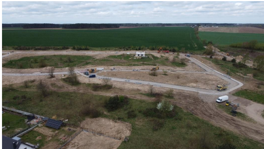
Rycina 28. Osiedle Północ – realizacja zadania budowa dróg wraz z siecią kanalizacji sanitarnej, wodociągowej i deszczowej na Osiedlu Północ.
